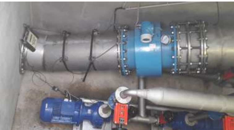
Beispiel: Ultraschall-Laufzeitmessung als Referenzmessung
